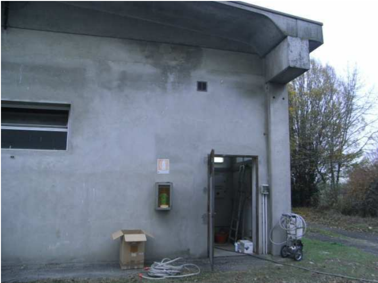
Centrale termica - esterno
